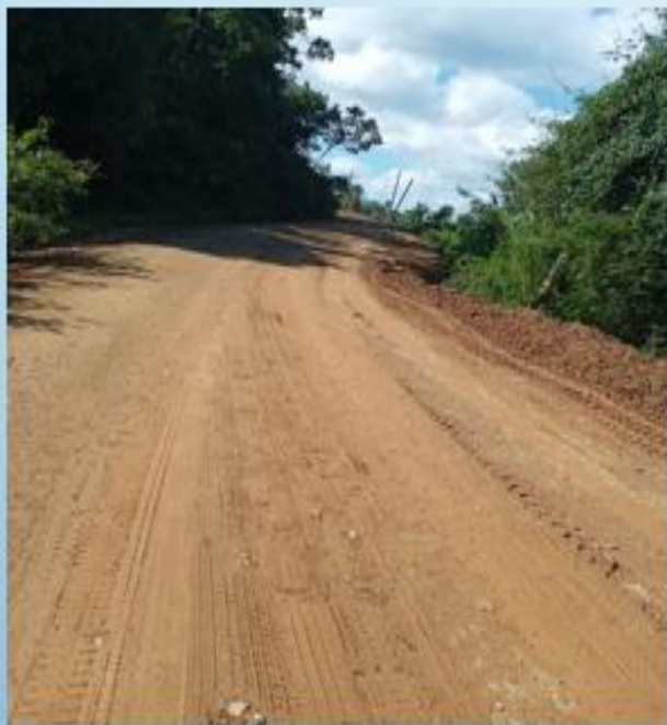
TRAMO TRUJILLO SANTA FE
