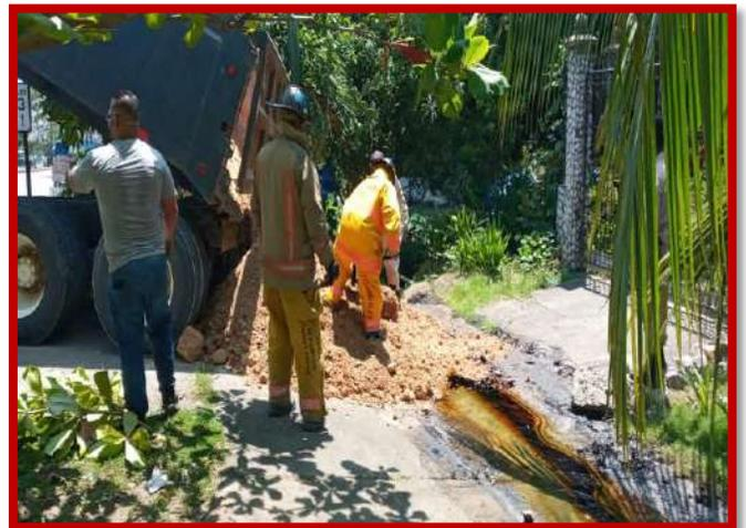
Atención de accidente de cisterna, control y mitigación de derrame de fuel oil (bunker) producido a raíz del incidente en canales pluviales de la Comunidad de Baracoa, Cortés.
