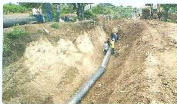
Instalación línea de conducción en el proyecto Cono Sur
