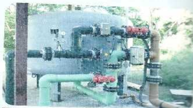
Filtros a presión para purificación de agua en la zona Sur
