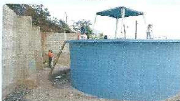
Finalización del tanque en la Col. Quebrachitos.
