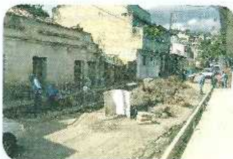
Cambios de tubería, y ramales y colectores en Barrio Lempira.
