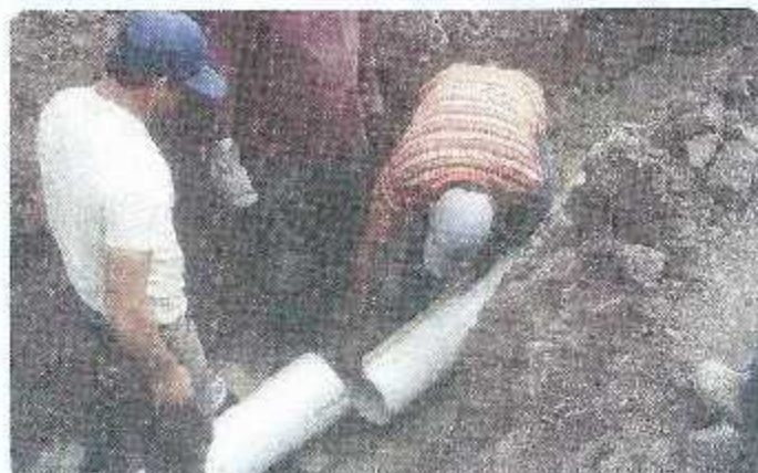
Kilómetros de tubería se han instalado en el proyecto de la colonia de la salida a Olancho.
