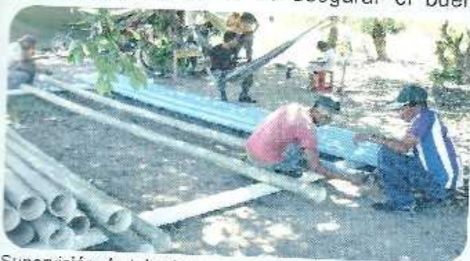
Supervisión de tubería y preparación de un proyecto de agua.
