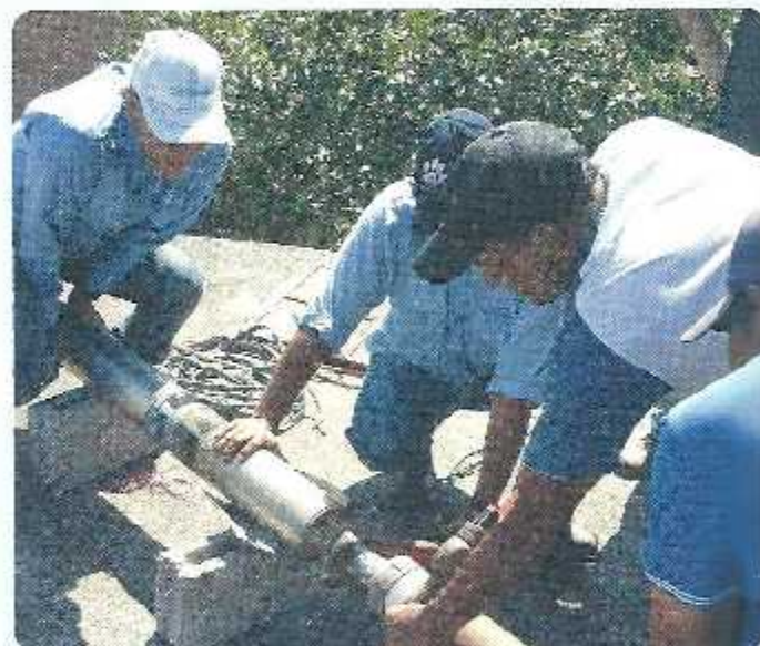
Revisión de bomba de agua previo a su instalación final.
