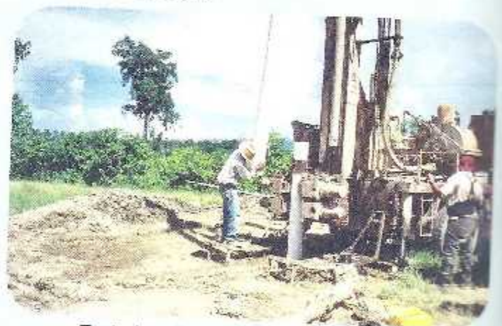
Trabajos de perforación de pozos, San Marcos de Colón, Choluteca.
