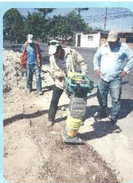
Compactación de terreno
