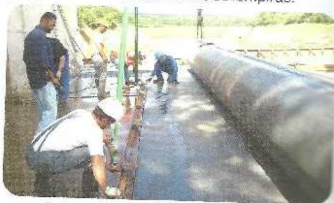
Trabajos de instalación de la presa inflable
