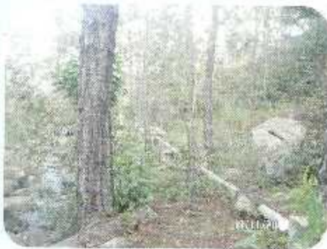
Instalación de la línea de conducción
