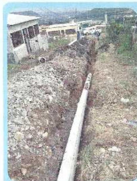
Instalación de Tubería
