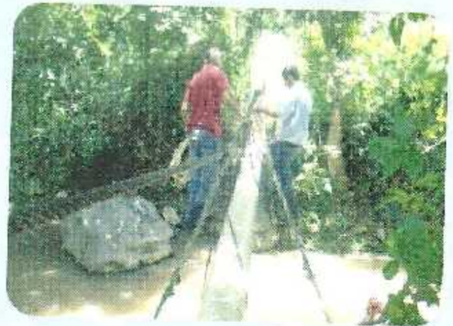
Mantenimiento preventivo en una importante línea de conducción de agua que abastece a la ciudad de La Entrada Copán.
