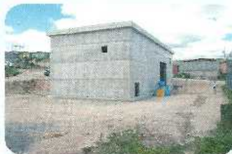
Edificio casa de máquinas Concepción
