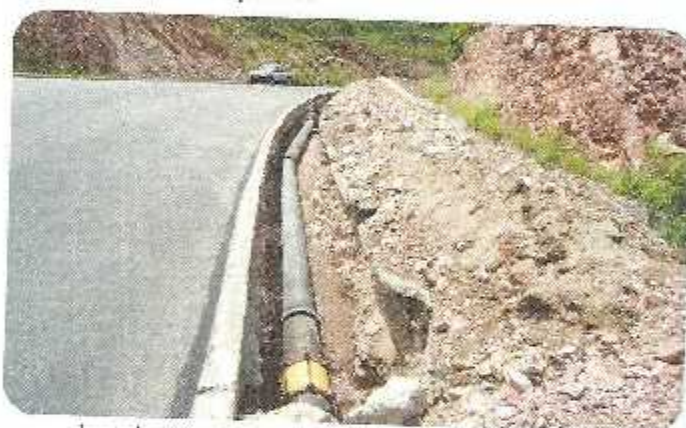
Instalación de tubería en la salida a Olancho
