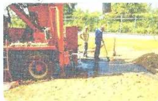
Maquinaria de perforación de pozos utilizada en diferentes zonas para dotar con agua a la población.
