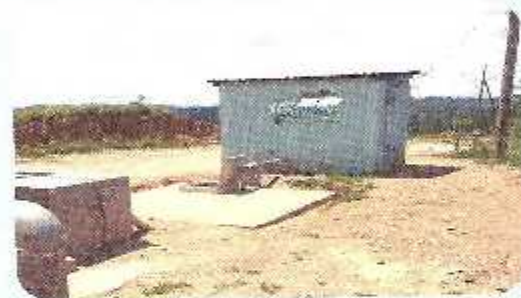
Caseta de Bombeo, Cisterna, cámara distribuidora en Campamento, Olancho.
