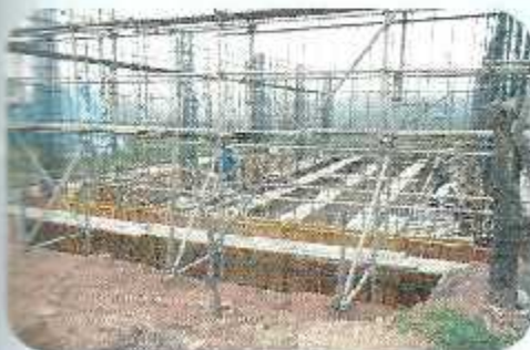
Armado de hierro paredes casa de máquinas Concepción
