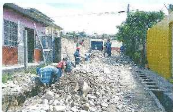
Nueva tubería se instala en la colonia Reynel Fúnez.
