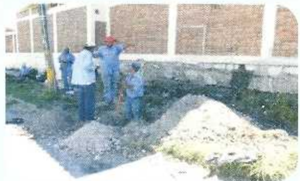
Labores de mantenimiento en el sector de la colonia Kennedy
