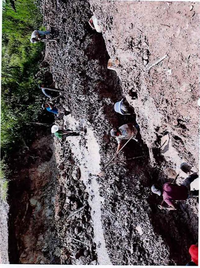
*Excavación para fundición de bases con piedra y concreto para bases de puente*
