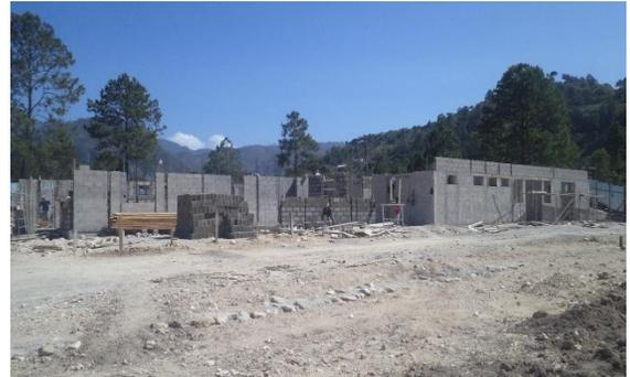
Muro frontal de relleno terminado y fachada lateral izquierda
