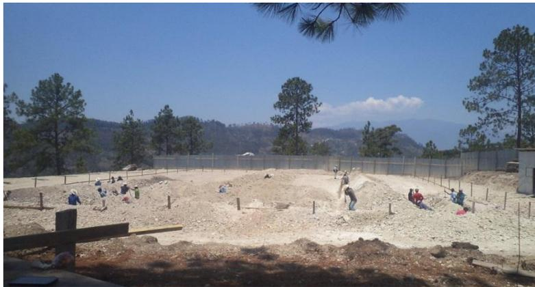
**Actividades de marcado, nivelado y excavación en terreno duro tipo roca.**
