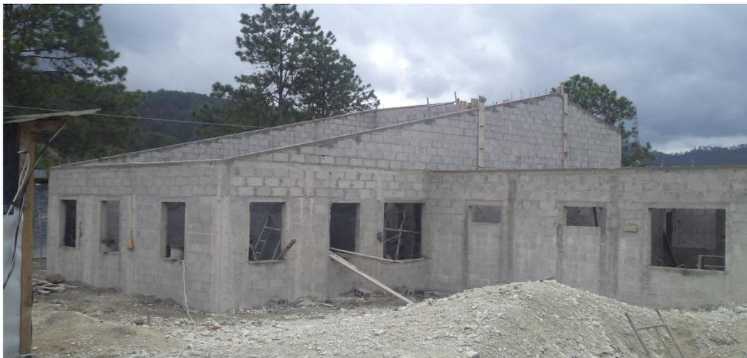
Construcción de paredes culatas a una altura de 3.00 mts.
